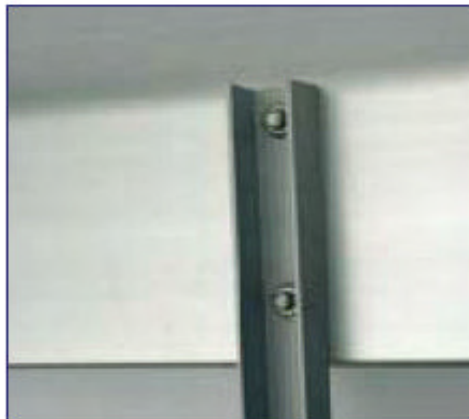
2) Svislý profil přišroubovat ke sbírači.
